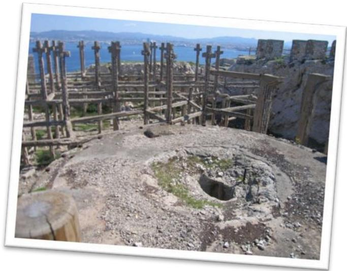
La réponse est plus basique, ces croix sont un ensemble destiné à caler le ferrailage d'un encuvement d'artillerie que les allemands n'eurent pas le temps d'achever. Il manque juste 4500 m<sup>3</sup> de béton.
